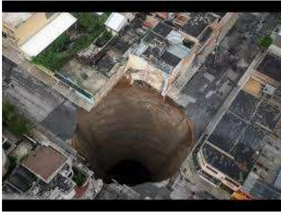
Figura 9. Hundimiento de tierra
