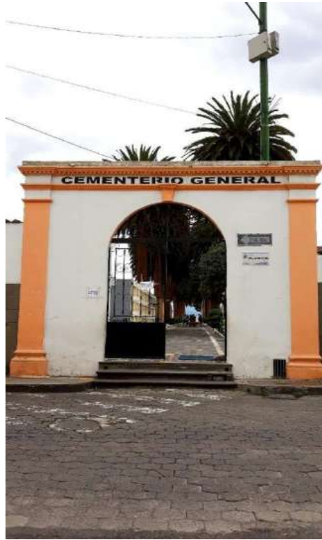
Fotografía 1: Entrada principal al cementerio.
